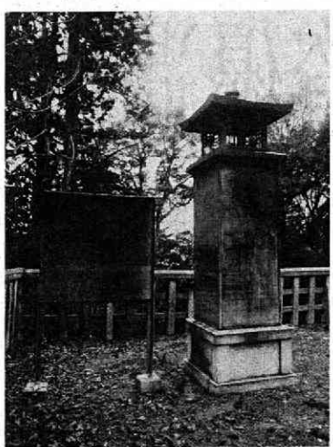
伊勢湾台風復興の寄進碑。本堂火災で変色したが焼失は免れた。
